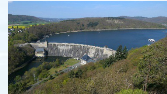
Talsperre --> Batterie und Gleichstrom
